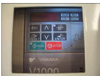
Рис. 65: Индикация неисправностей на дисплее преобразователя частоты
