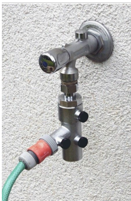
Att. 1: Piemēram, sistēmas atdalītājs Honeywell BA295STN
