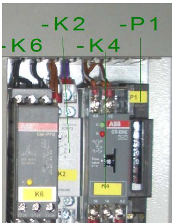
Illustration 50 : valeurs de réglage du relais temporisé
