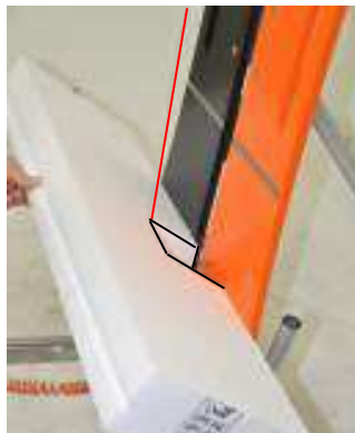
Slika 9: Urezi za krovnu gredu
