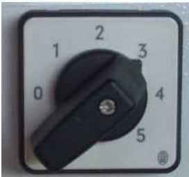
Şek. 12: Seçim anahtarı Pompa motoru konumu
