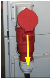
Şek. 82: Bağlantı kablosunu çıkarma
