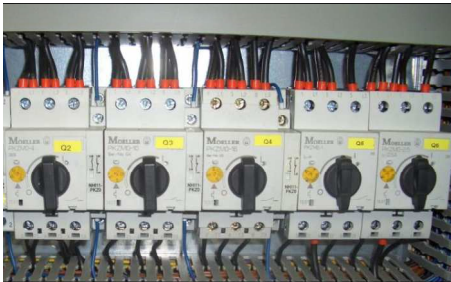
Şek. 1: Motor koruma anahtarı
