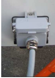
Şek. 26: Pompa motoru konnektörü
