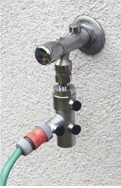
Şekil 1: örn. Honeywell BA295STN ters akış önleyici
