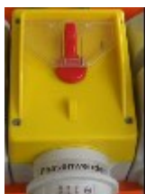
ilustracja 2: Wyłącznik główny
