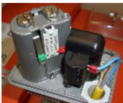
Фигура 65: Превключвател на налягане
