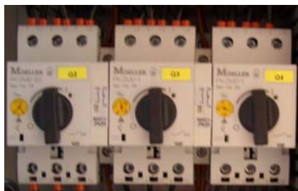
Фигура 4: Предпазен изключвател за мотора
