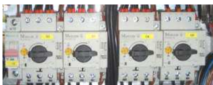
Мал. 1: Запобіжний вимикач двигуна
