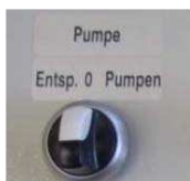
Obr. 12: Provozní režimy motoru čerpadla
