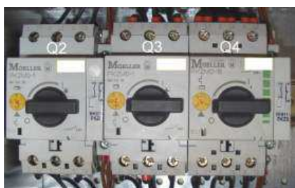
Fig. 1: Interruptor protección del motor
