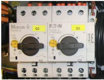
Fig. 1: Interruptor de protección del motor
