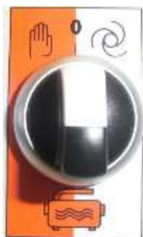
Figura 21: Selector de la bomba de aumento de presión
