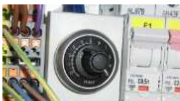
Figura 36: Potenciómetro
