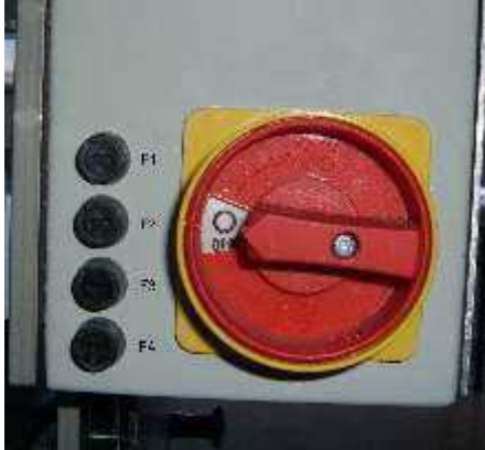
Линейный выключатель 0-1 с расцепителем пониженного напряжения.
