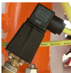
Рис. 101: Мембранный выключатель по воде
