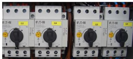
Рис. 1: Защитный выключатель электродвигателя
