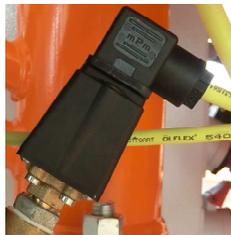
Рис. 112: Мембранный выключатель по воде
