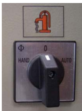
Fig. 12: Modos de funcionamento da Bomba de aumento de pressão
