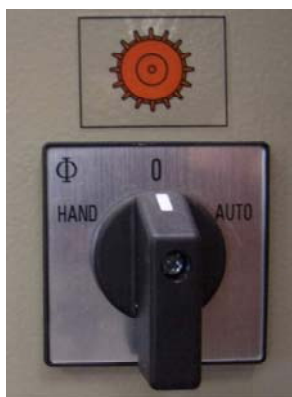
Fig. 11: Modos de funcionamento da roda celular
