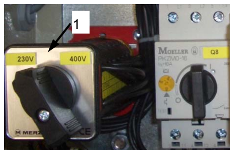
Fig. 15: Seletor de tensão
