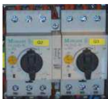
Rys. 1 Wyłącznik ochronny silnika
