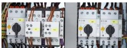
ilustracja 4: Samoczynny wyłącznik silnikowy
