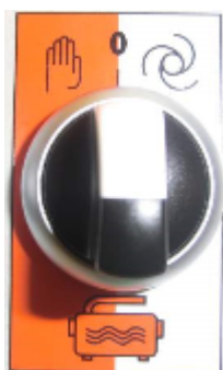
ilustracja 19: Przełącznik pompy podwyższającej ciśnienie
