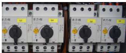
ilustracja 4: Samoczynny wyłącznik silnikowy
