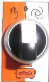
Afbeelding 19: Selectieschakelaar drukverhogingspomp
