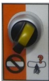
Afbeelding 20: Selectieschakelaar niveausonde
