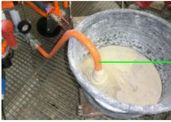
Afbeelding 59: Consistentie controleren
