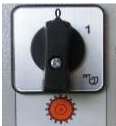
Afbeelding 19: Keuzeschakelaar waaier
