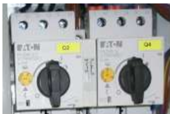
Afbeelding 4: Motorbeveiligingsschakelaar
