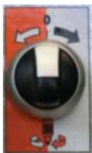
Afbeelding 20: Keuzeschakelaar pompmotor
