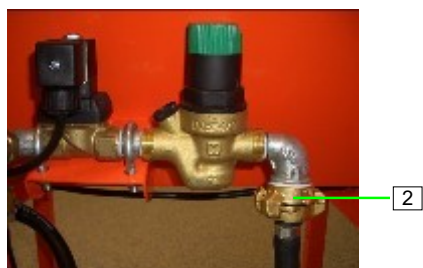
slika 16: Priključak vode bez pumpe za povećanje tlaka
