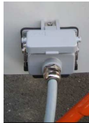
Fig. 25: Allacciamento motore pompa
