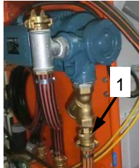
Fig. 69: Staccare il tubo flessibile dell'acqua
