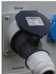
Fig. 24: Allacciamento motore miscelatore
