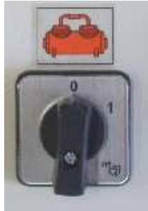
Fig. 15: Modalità operativa del compressore d'aria
