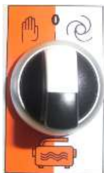
Figura 21: Selettore pompa di aumento di pressione
