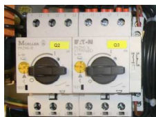
Illustration 1 : Disjoncteur-protecteur
