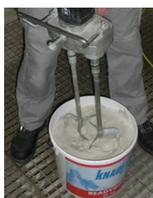
Illustration 27 : Mélange du matériau
