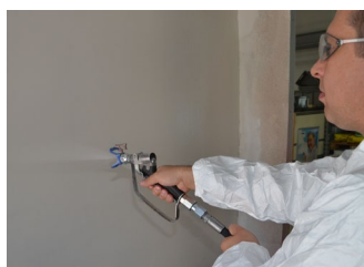
Illustration 46 : Pulvérisation du matériau
