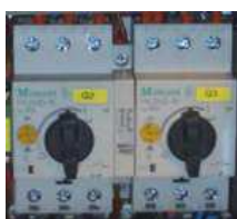
Fig. 1 : Disjoncteur de protection du moteur
