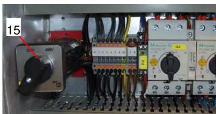
Fig. 14 : Commutateur-sélecteur 230V - 400V
