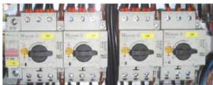
Figure 4 : Disjoncteur-protecteur
