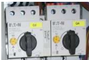
Figure 4 : Disjoncteur-protecteur
