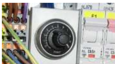
Figure 36 : Potentiomètre
