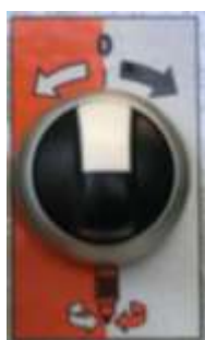
Figure 19 : Commutateur-sélecteur du moteur de la pompe
