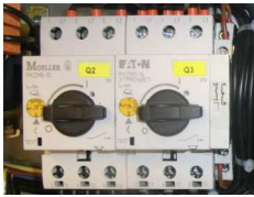
图 1: 电机保护开关
