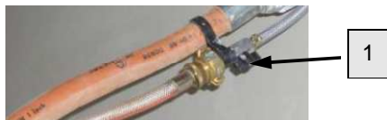
图 55: 关闭空气旋塞
