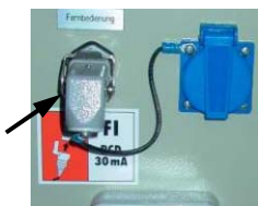
Abb. 20: Fernsteuerung anschließen
