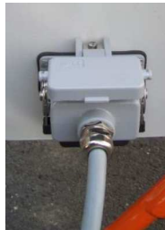
Abb. 26: Anschluss Pumpenmotor
