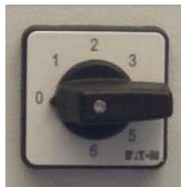
Abb. 15: Wahlschalter Mischer leer fahren
