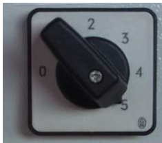
Abb. 14: Wahlschalter Pumpe entspannen
