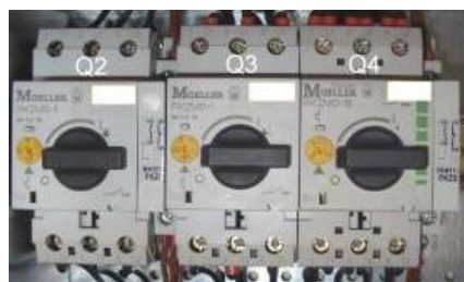
Abb. 4: Motorschuttschalter
