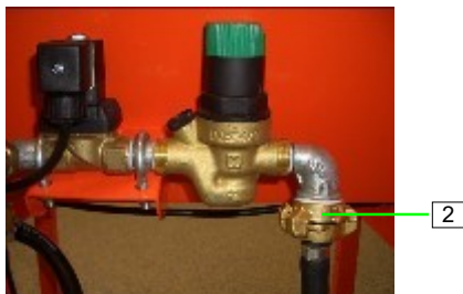
Abb. 16: Anschluss Wasser ohne Druckerhöhungspumpe
