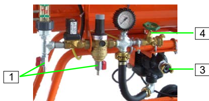
Abb. 26: Anschluss Wasserversorgung mit Druckerhöhungspumpe
