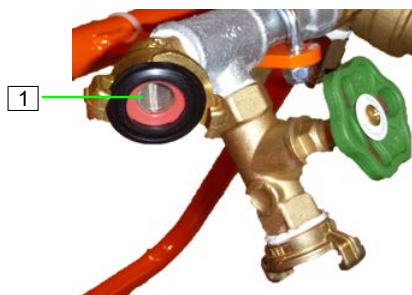
Abb. 19: Schmutzfängersieb Wassereingang
