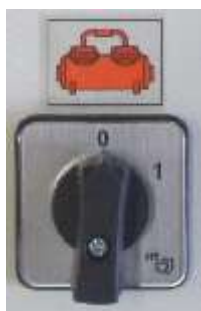
Abb. 22: Wahlschalter Luftkompressor
