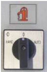
Abb. 21: Wahlschalter Druckerhöhungspumpe
