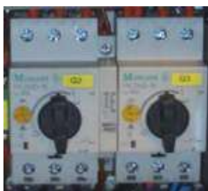
Abb. 5: Motorschutzschalter
