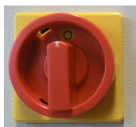
Abb. 90: Wahlschalter für Heizband
