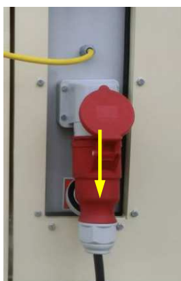
Abb. 92: Anschlusskabel entfernen
