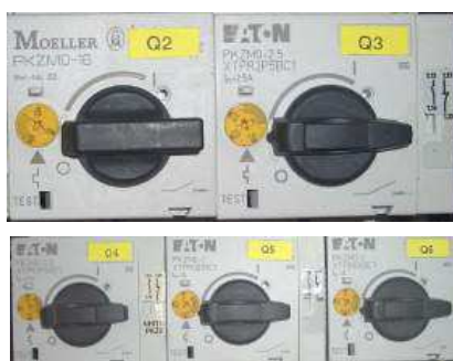
Abb. 1: Motorschutzschalter
