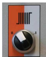
Abb. 90: Wahlschalter für Heizband
