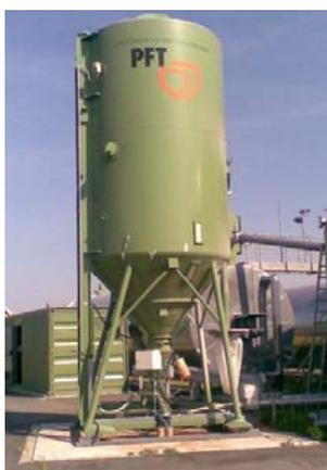
Silo / Container mit Pumpen standsicher auf einer betonierten Fläche stellen.
