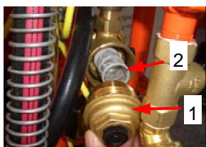
Abb. 75: Sieb für Druckminderer
