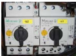
Abb. 4: Motorschuttschalter
