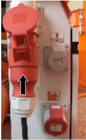
Abb. 14: Stromversorgung anschließen
