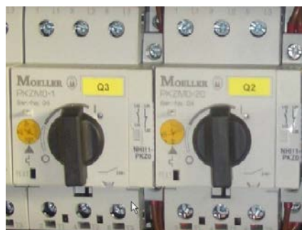
Abb. 4: Motorschuttschalter
