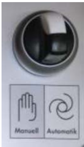
Abb. 12: Wahlschalter Rotationskompressor
