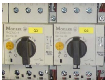
Abb. 4: Motorschutzschalter
