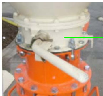
Abb. 33: Siloeslaufklappe schließen
